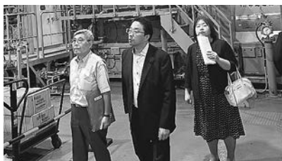
令和6年度産炭地振興・エネルギー調査特別 委員会道内調査鷺泊・沓形発電所
