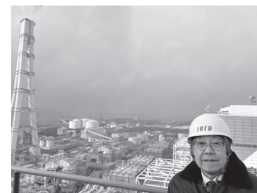
(エネ特道外調査) 愛知県碧南火力発電所 (1/25)
