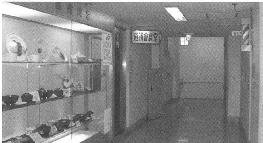
老朽化が著しい道議会庁舎
