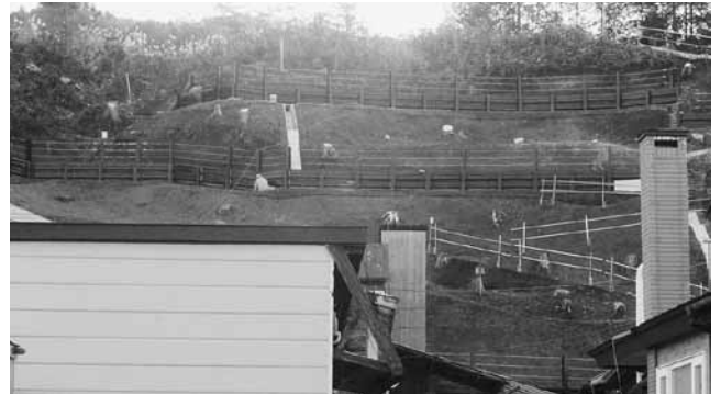
土砂災害警戒指定区域内での急傾斜工事の様子
