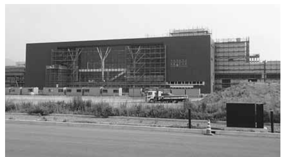
建設中の新函館北斗駅
