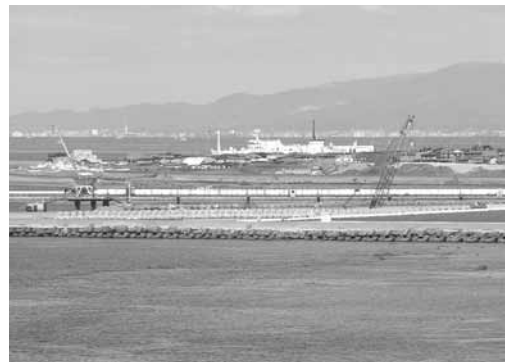
大間原発から函館市内を望む (写真は、大間原発の配管関係)
