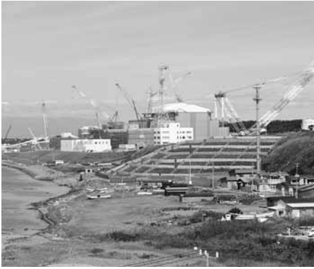
建設工事を再開し、外構工事などを進める大間原発
