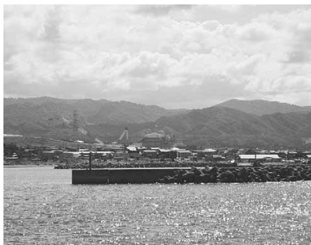
大間港より見える建設中の大間原発（9月24日）
